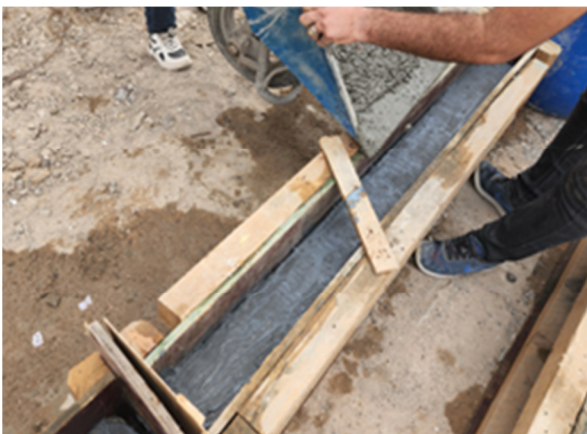
Fig. 3. Pouring old concrete layer.
