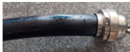
Fig. 14. Bursting in Pipe I.
